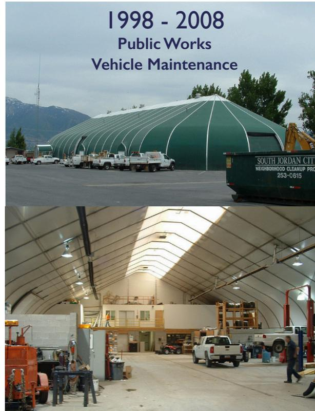
Das Gebäude wurde demontiert und in das Sprung-Werk in Utah zurück gesendet wo es überarbeitet und gereinigt wurde. Die Struktur wurde mit zusätzlichen Türen, Fenstern und einer Isolation ergänzt. 1998 wurde das Gebäude dann auf einem neuen Grundstück der Stadt, als Fahrzeugwartungs- und Schulungszentrum wieder aufgebaut, wo es bis November 2008 verblieb.
